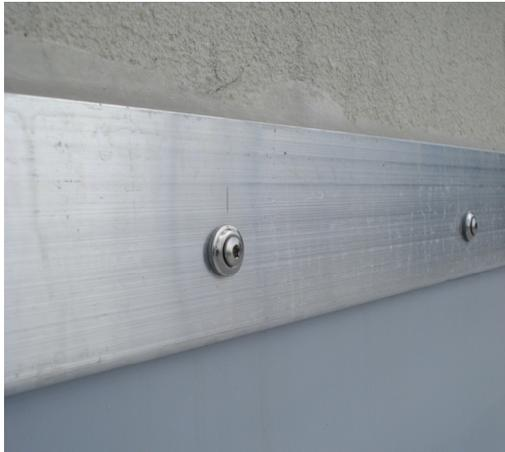
COMETEC-Wandanschlußprofile sind richtungweisend in der Anschlußtechnik. Stabilität, Form und Fugenausbildung garantieren eine lange Nutzungsdauer für dauerhaft dichte Wandanschlüsse.
